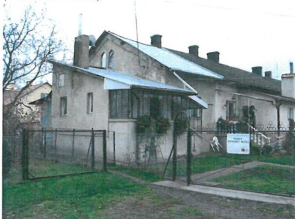
Rys. 15 Budynek mieszkalny położony w południowej części działki nr 3205/81 – widok od północy (Fot. Anna Polska)
