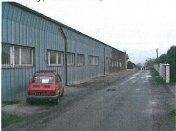
Rys. 7 Budynek produkcyjny przy ul. Spółdzielczej (Fot. Anna Polska)
