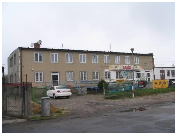
Rys. 2 Budynek usługowo-biurowy przy ul. Spółdzielczej 1 (Fot. Anna Polska)
