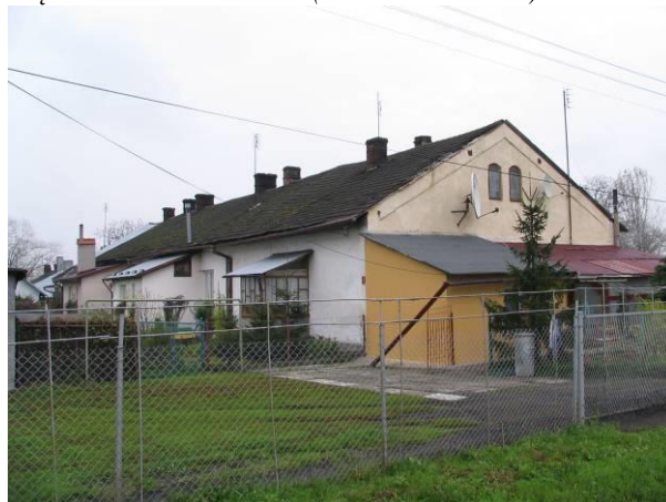
Rys. 16 Budynek mieszkalny położony w południowej części działki nr 3205/81 – widok od południa (Fot. Anna Polska)
