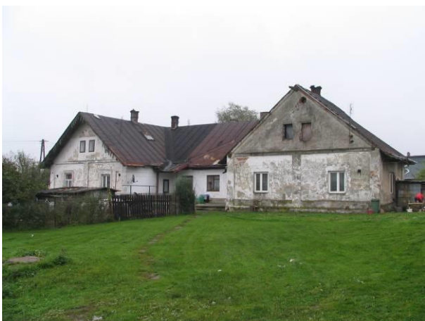
Rys. 13 Budynek mieszkalny na działce nr 3205/21
