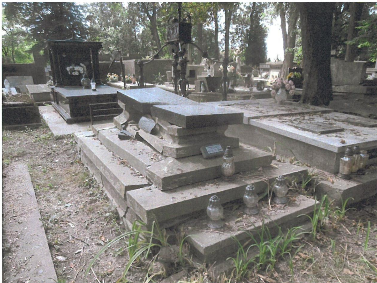
Pomnik nagrobny dr Tadeusza Fechterera przed rozpoczęciem prac konserwatorsko-rekonstrukcyjnych.
